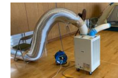
スポットクーラーの設置
