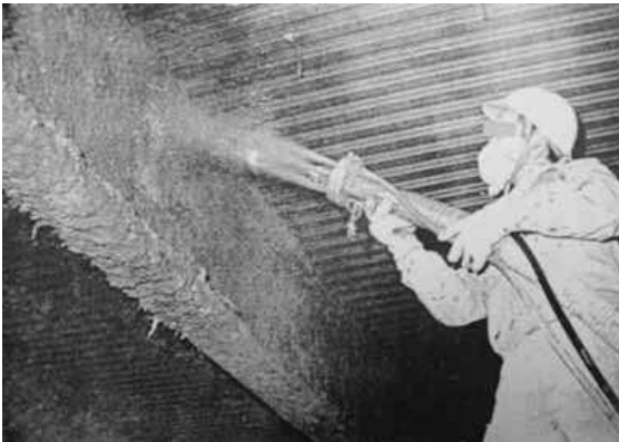
鉄骨梁への吹き付け塗装
