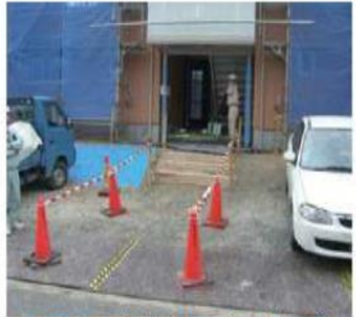
* トラテープで敷鉄板の段差も改善
