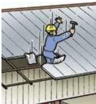
「屋根の踏み抜き・墜落」
