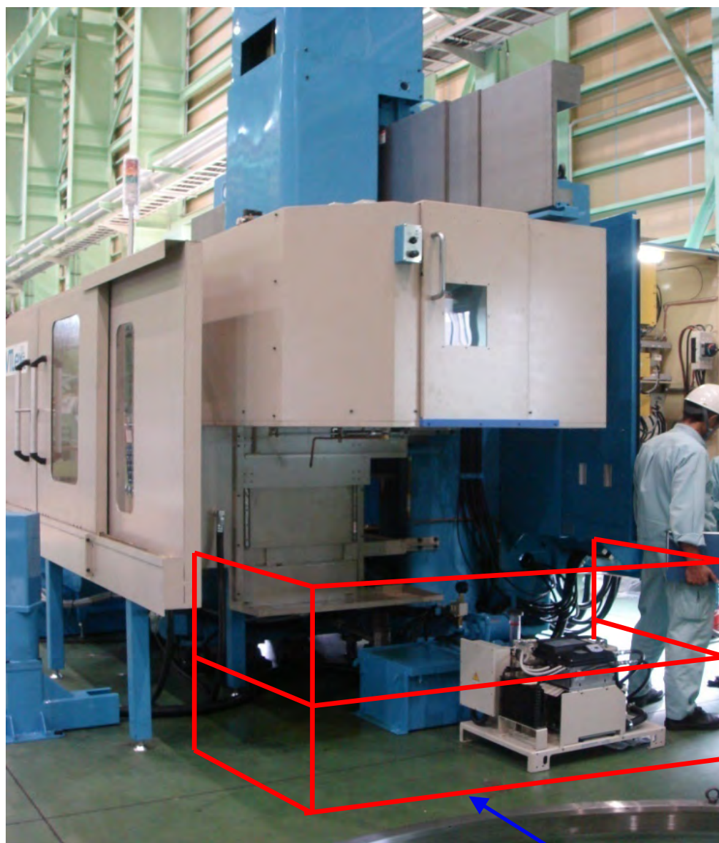
安全柵の設置
